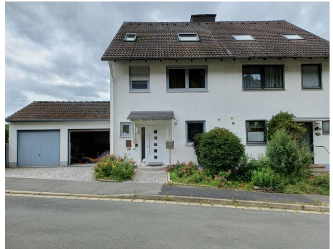
Energiebedarfsausweis in Bearbeitung
