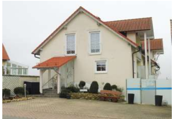
Energieverbrauchsausweis, 109,0 kWh/(m 2 a), Öl, Kl. D
