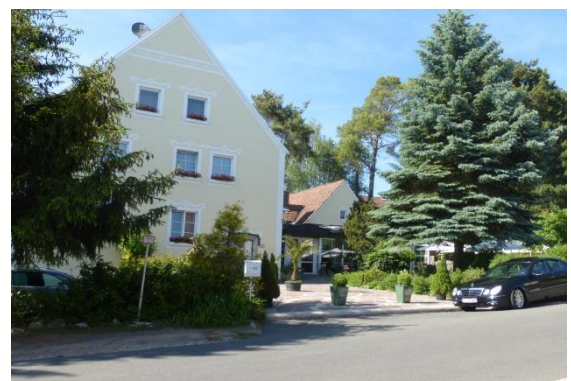
Energiebedarfsausweis, 154,6 kWh/(m² a), Öl, Kl. E
