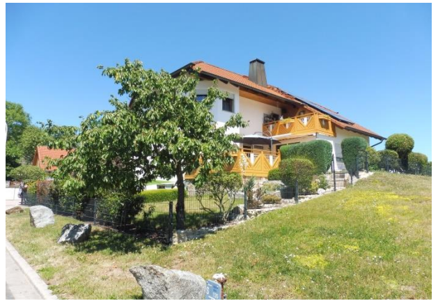
Energieverbrauchsausweis, 107,8 kWh/(m 2 a), Öl, Kl. D
